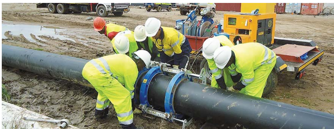
Укладка и сварка водопроводной трубы
